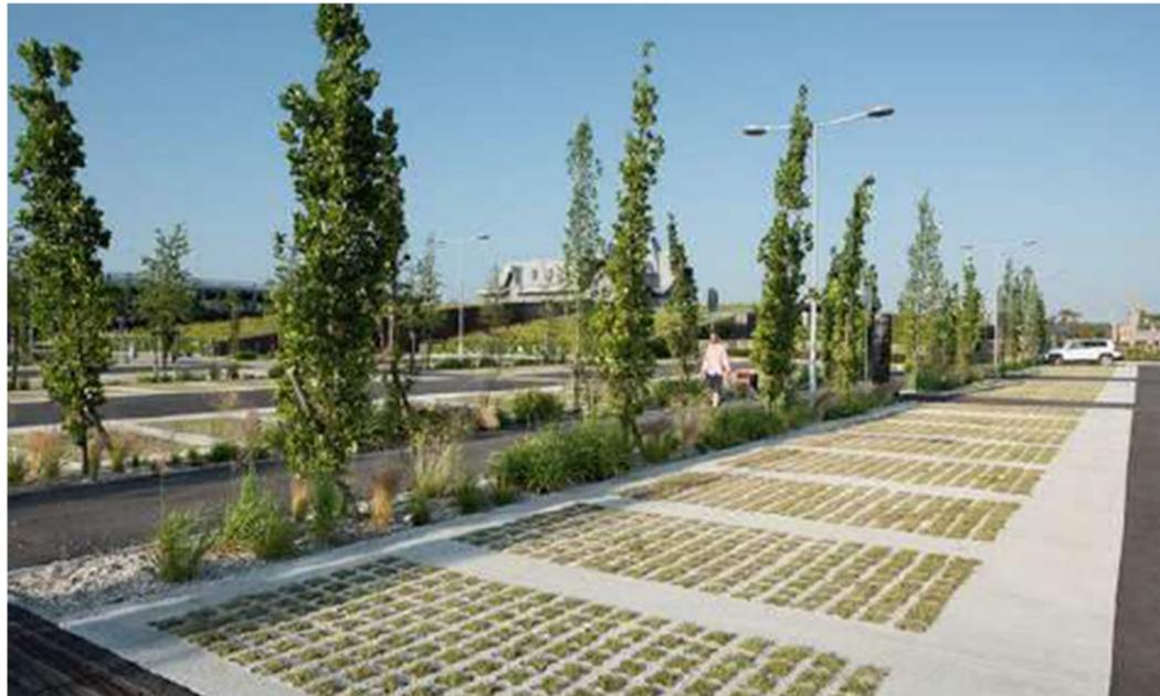
Revêtement infiltrant – béton enherbé
